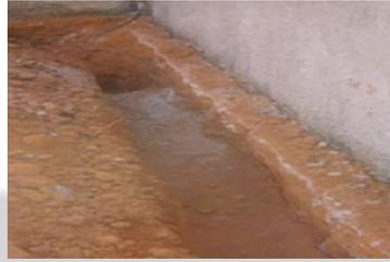
Se coloca una capa de tierra sin piedras de 10 cm aproximadamente bien compactada, se coloca una capa de 5 cm del compuesto electroacondicionador higroscópico, con la cantidad de agua apropiada para lograr una buena compactación, posteriormente se coloca el cable, y nuevamente una capa de 5 cm de compuesto electroacondicionador higroscópico, por último se rellena la zanja de tierra sin piedra bien compactada.
