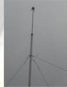
Fijación del mástil a la estructura de la torre con soporte de punta, abrazaderas de acero galvanizado ó tensores de acero. La punta del pararrayos siempre debe ser el punto más elevado de una instalación.
