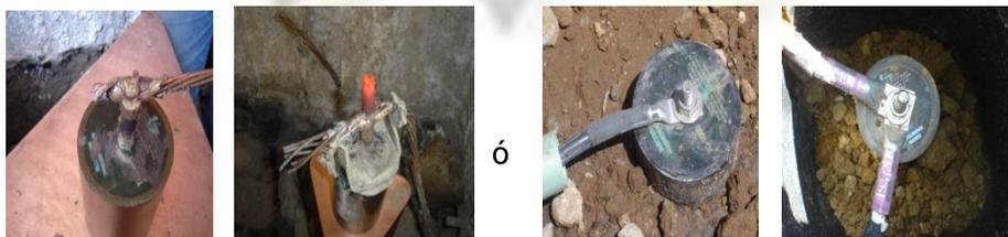
Conexión del borne inferior del acoplador al dispositivo LCR Terragauss, puede ser con soldadura exotérmica ó con conectores de compresión.
