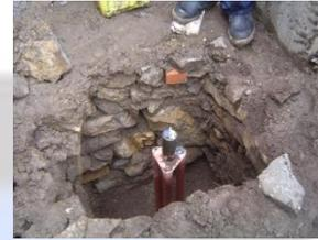
Una vez ubicado el electrodo en el centro de la fosa, se procede a orientar cualquiera de las puntas hacia el Polo Norte (N). Se coloca la brújula suministrada en el kit sobre cualquiera de las esquinas del electrodo, la N (Norte) debe quedar en la punta, girar el electrodo hasta que la aguja (de color), esté sobre la N (Norte).
