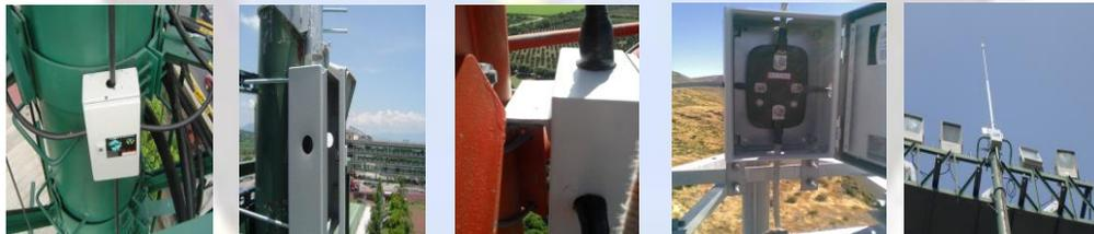
Fijación del acoplador con unicanal ó con cinchos y conexión del borne superior del acoplador a la punta de aluminio anodizada. El cable debe quedar aislado del mástil.
