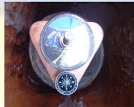
El siguiente paso en la instalación, una vez orientado el electrodo, es la nivelación del mismo para lo cual se coloca el nivel suministrado en el kit, sobre uno de los tres lados del electrodo y se nivela (la burbuja debe quedar en el centro). Se repite esta operación en los otros dos lados del electrodo.
