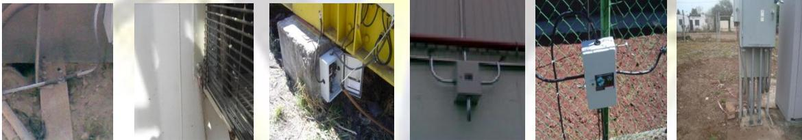
Conexión de los **dos bornes** laterales del acoplador a estructuras metálicas tales como: acero de construcción, acero de refuerzo, través, columnas de acero, castillos en columnas de concreto, tuberías de agua metálicas, cercas metálicas, cubas, charolas, tierras existentes o cualquier estructura metálica enterrada. **Se recomienda usar diferentes estructuras metálicas para cada borne.**
