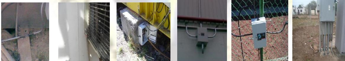
Conexión de los **dos bornes** laterales del acoplador a estructuras metálicas tales como: acero de construcción, acero de refuerzo, través, columnas de acero, castillos en columnas de concreto, tuberías de agua metálicas, cercas metálicas, cubas, charolas, sistemas de tierras existentes o cualquier estructura metálica enterrada. **Se recomienda usar diferentes estructuras metálicas para cada borne.**
