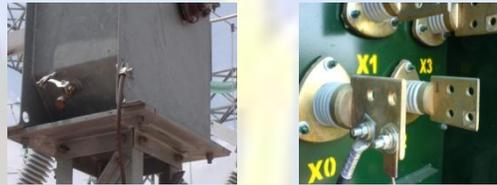
Conexión del borne superior del acoplador al  $X_0$ /carcasa del transformador. De no haber la conexión entre el  $X_0$  y la carcasa, el borne superior va al  $X_0$  y una de las laterales se conectará a la carcasa.
