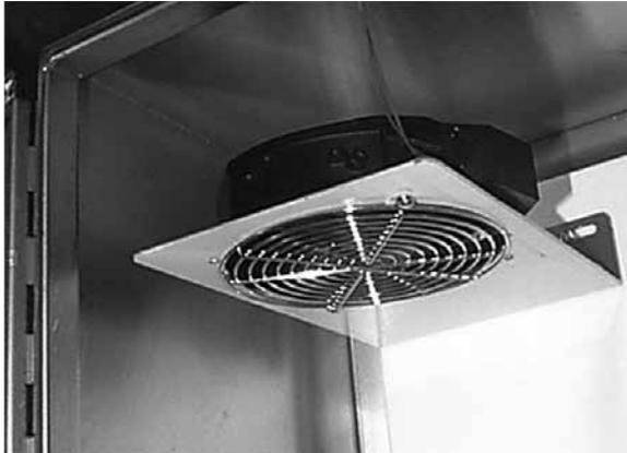
El uso de ventiladores de circulación en el interior de un gabinete mejorará la disipación de calor en un 10%. Los ventiladores de circulación por lo general se utilizan para eliminar zonas calientes en el interior de un gabinete.
